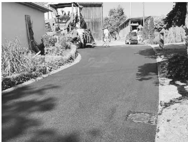
Das Bild zeigt die Asphaltarbeiten in Gauchshausen.
