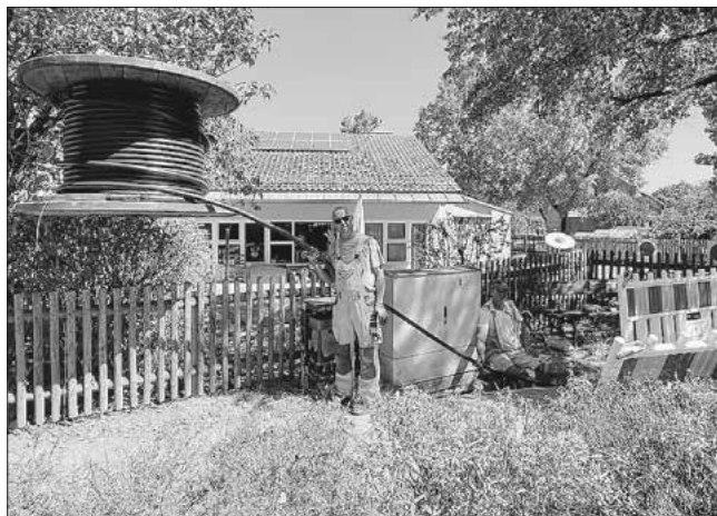
Auf dem Bild sind Peter Müller (links) und Thomas Hofmann (rechts) beim Einziehen des neuen Kabels im Bereich des Kindergartens Honhardt zu sehen.
