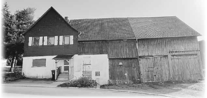
Das gemeindeeigene Anwesen Friedhofweg 4 soll abgerissen werden.
