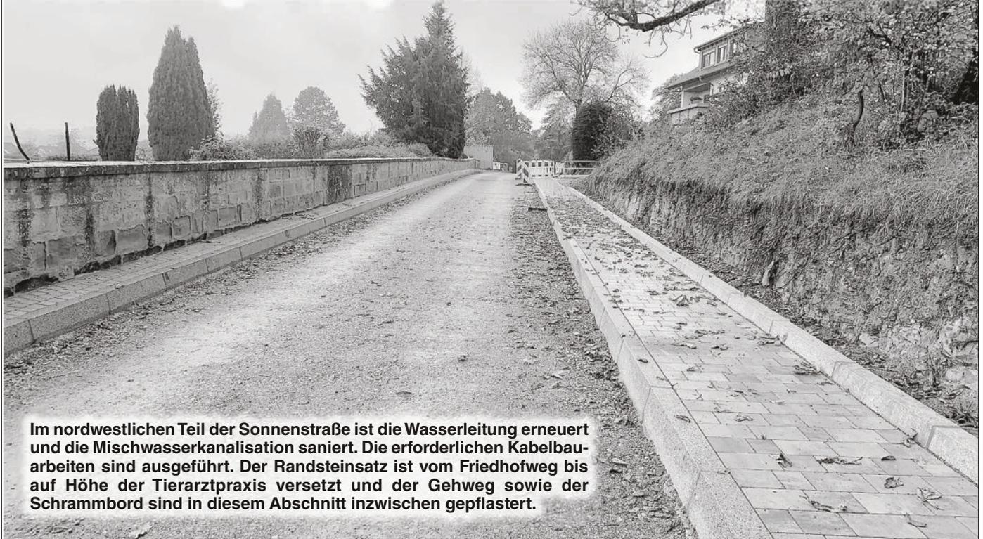
Im nordwestlichen Teil der Sonnenstraße ist die Wasserleitung erneuert und die Mischwasserkanalisation saniert. Die erforderlichen Kabelbauarbeiten sind ausgeführt. Der Randsteinsatz ist vom Friedhofweg bis auf Höhe der Tierarztpraxis versetzt und der Gehweg sowie der Schrammbord sind in diesem Abschnitt inzwischen gepflastert.
